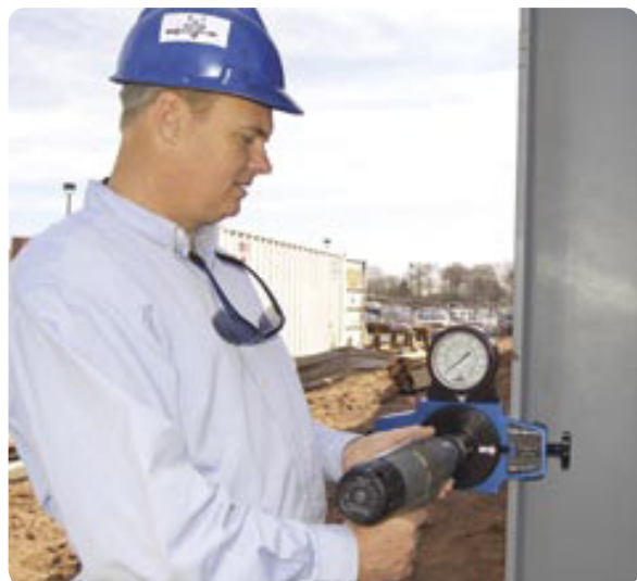
配套使用冲击扳手安装在横梁上
